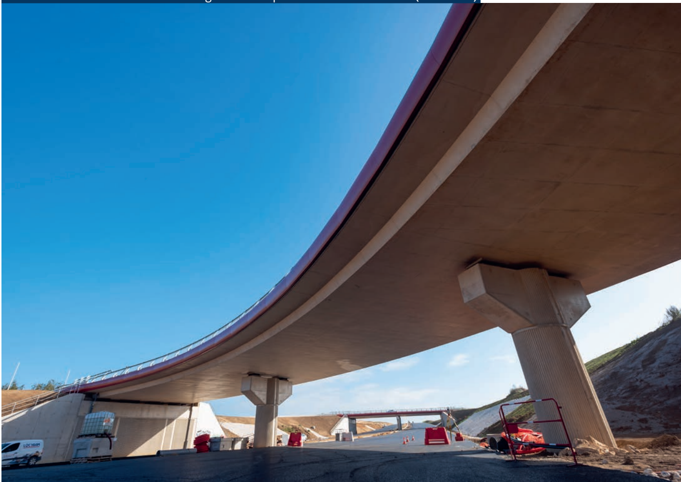
Octobre 2022 - Ponts raccordant le giratoire d'Epiais-lès-Louvres achevés (PS11 et 12)
