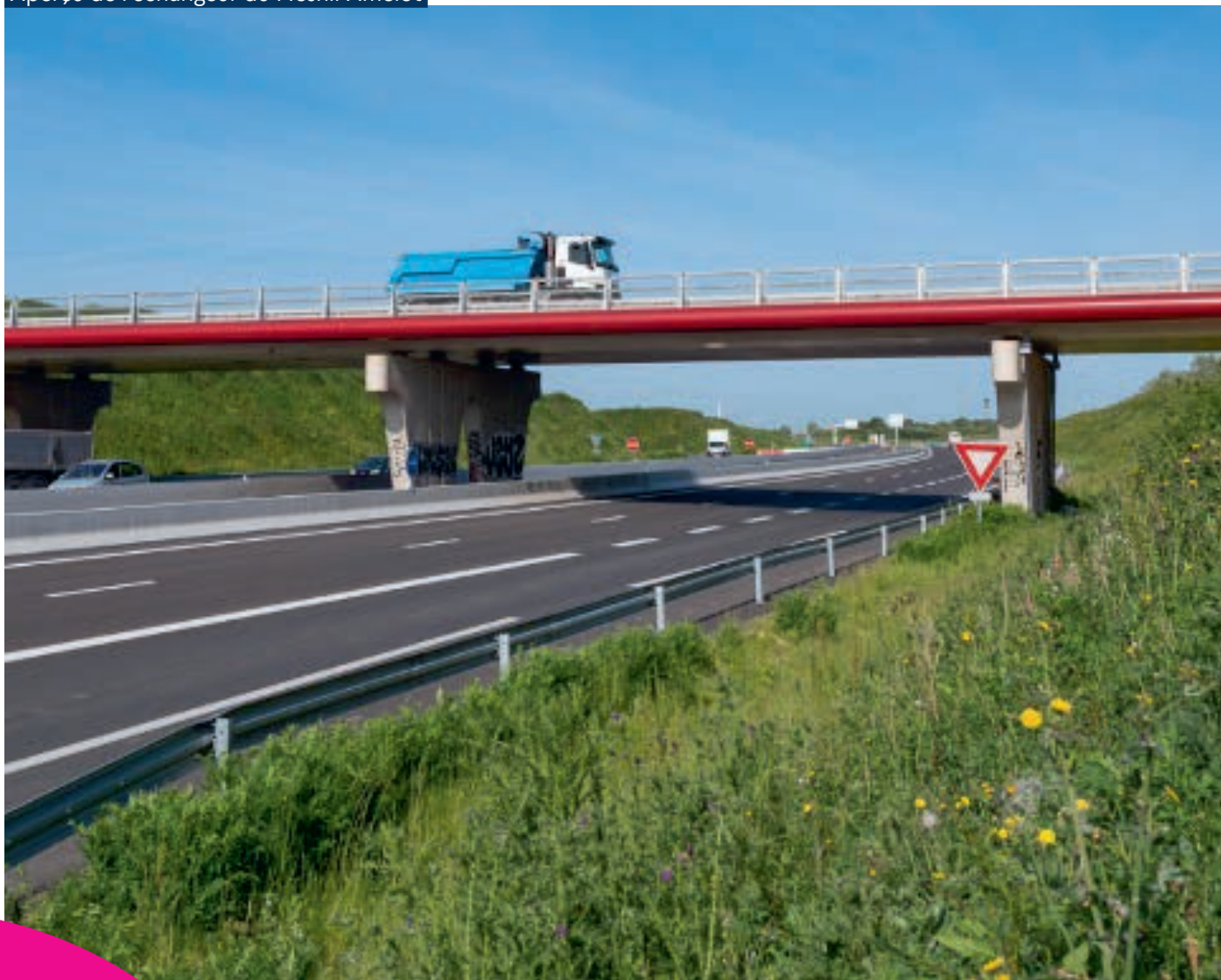
Aperçu de l'échangeur du Mesnil-Amelot
