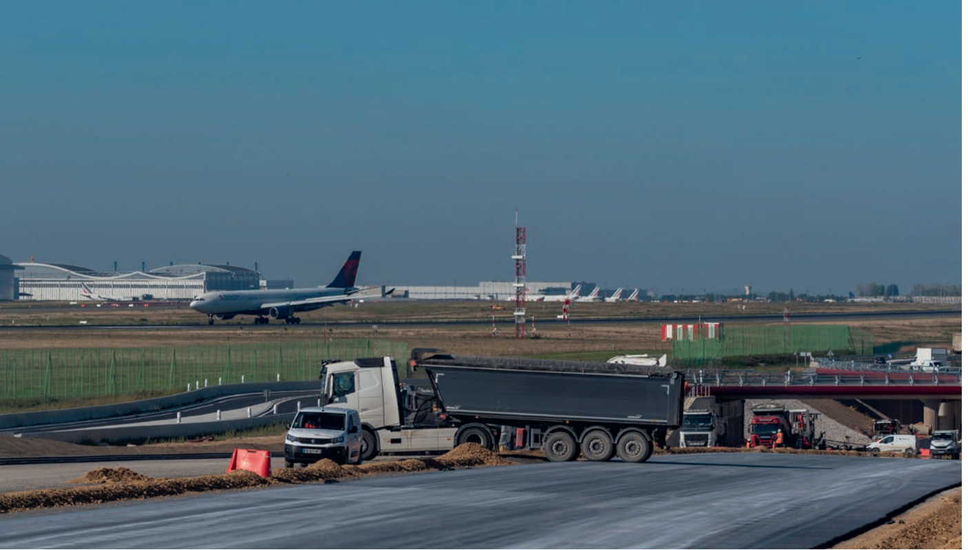
Septembre 2022 - Proximité des travaux avec les pistes d'atterrissage de l'aéroport Paris-CDG
