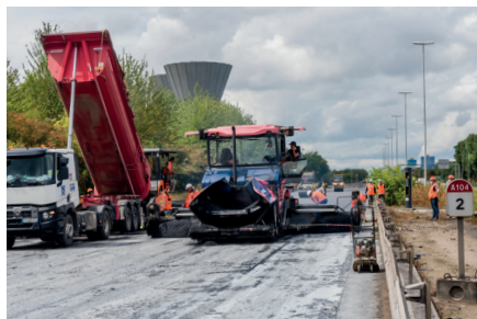
Rénovation des chaussées avec un enrobé à fort taux de recyclage
